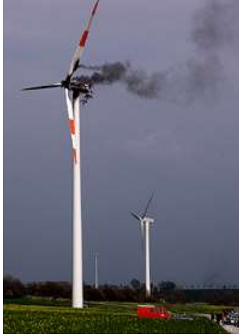
الشكل (5) احتراق التجهيزات الحساسة في علب السرعة نتيجة مرور تيار الصاعقة فيها.
